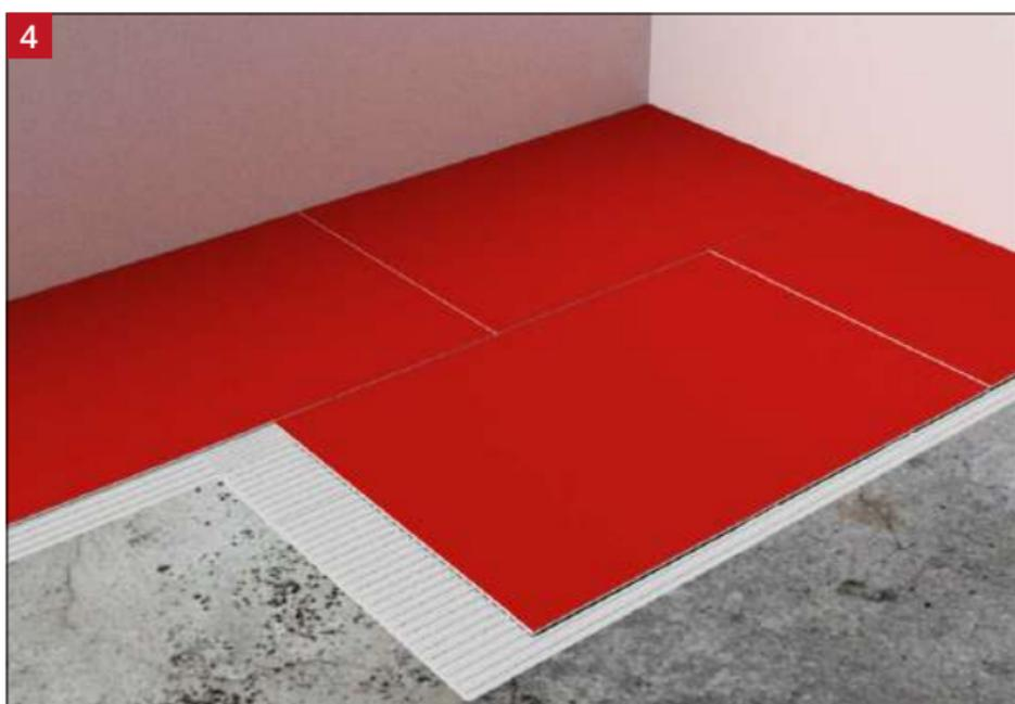
L'ultralight doit être posé sur le mortier colle fraîchement et soigneusement appliqué afin de s'assurer qu'aucun vide n'est laissé sous les panneaux et qu'ils soient solidement maintenus. Tous les panneaux doivent être posés en quinconce.
