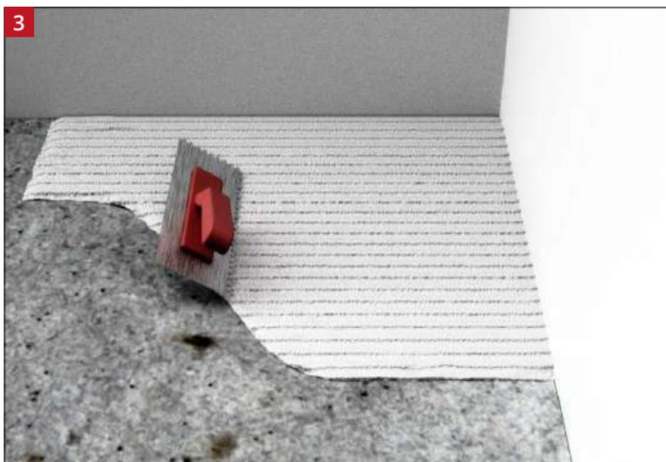
Ultralight doit être installé en utilisant un mortier colle adhésif. Il doit être appliqué à l'aide d'un peigne carrée de 6 mm x 6 mm pour donner une couche nervurée, toute légère dépression contre le support.
