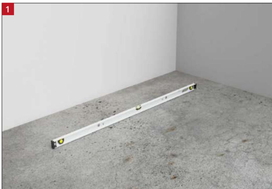
Le support doit être propre, sec et, si nécessaire, lissé avec un ragréage autonivelant pour avoir une surface uniforme.
