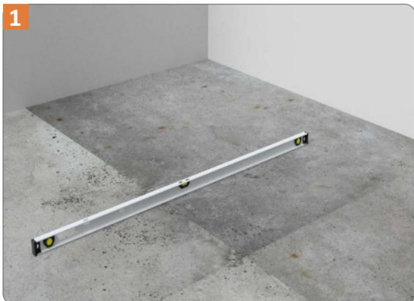
Le support doit être propre, sec et, si nécessaire, lissé avec un ragréage autonivelant pour avoir une surface uniforme.
