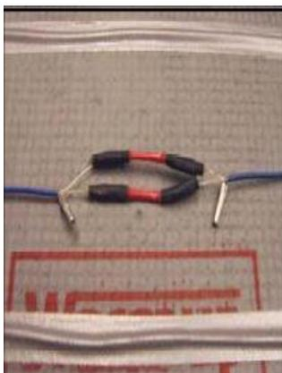
12. Enfiler un manchon sur les deux sections de la tresse exposée. Couper une section du fil de « pont » à longueur convenable pour remplacer le fil retiré du câble chauffant. Placer ce fil dans les manchons à sertir et pincer avec la pince à sertir.
