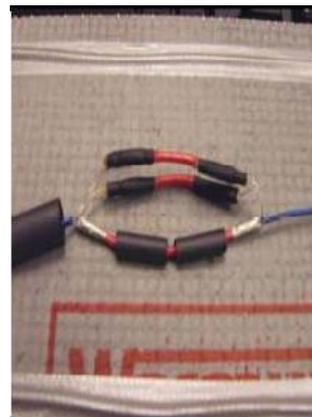
13. Enfiler les manchons thermorétractables afin de recouvrir toute la partie métallique et chauffer à l'aide du pistolet à chaleur.
