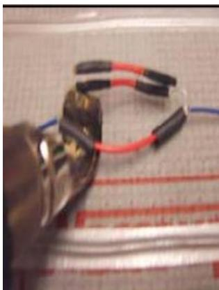
14. Enfiler le grand manchon thermorétractable et chauffer à l'aide du pistolet à chaleur. Laisser refroidir et mesurer la continuité.
