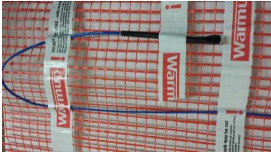
Figure 4 – la terminaison des éléments chauffants « Warmup Mat »
