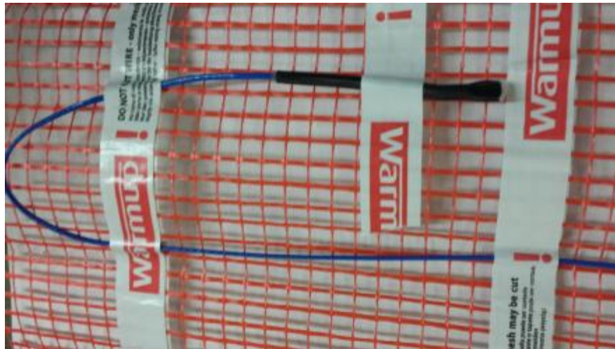
Figure 4 – la terminaison des éléments chauffants « Warmup Mat »
