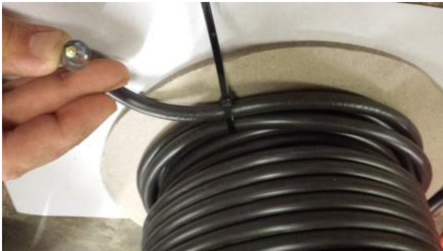
Figure 3 – la liaison froide des éléments chauffants
